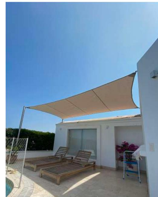
**1. Anclaje de Lona:** Los extremos de la lona son estirados y tensados hacia los anclajes. Es así como se logra regular el nivel de tensado de la lona.
